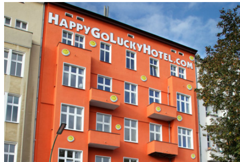
Bild 2: Die alte Fassade des Happy Go Lucky Hotel & Hostel
